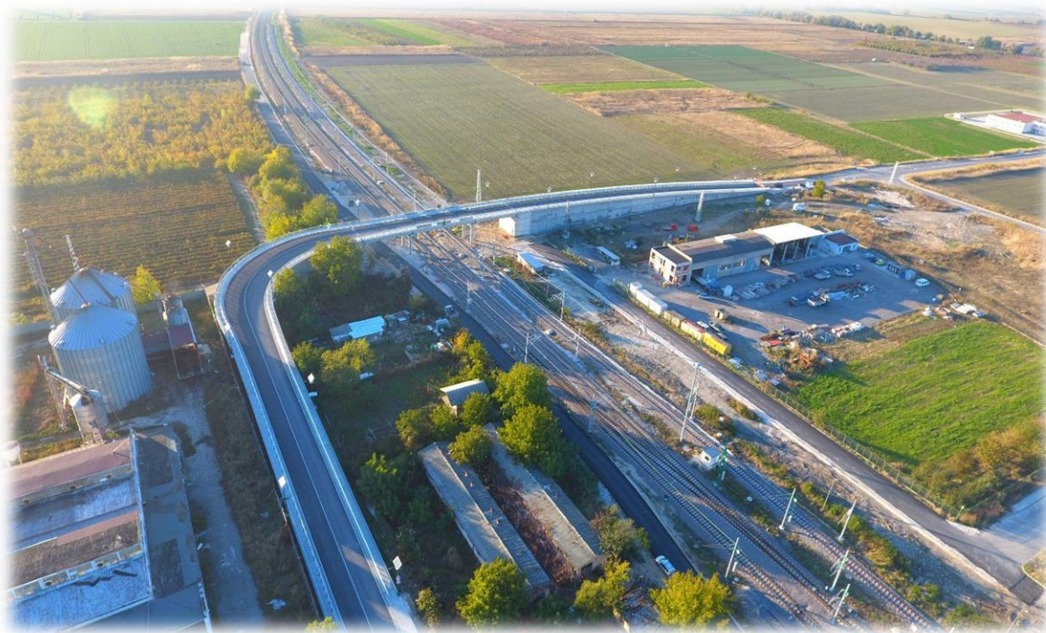
Надлез км. 146+269.20 района на гара Тодор Каблешков
